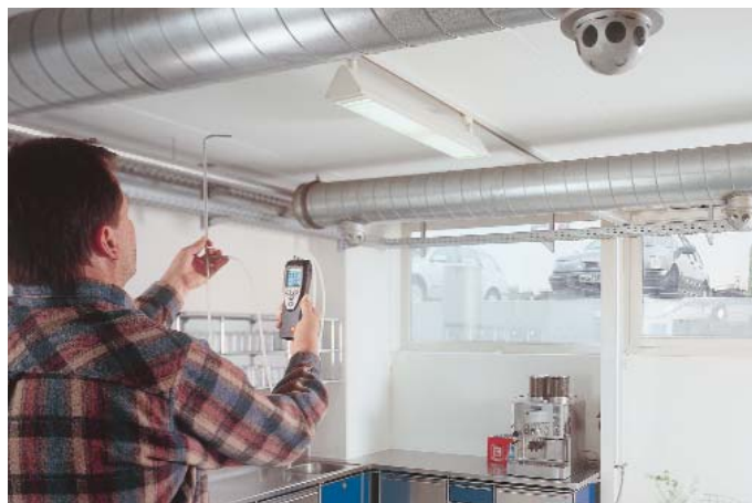
Měření vyfukovaného vzduchu
